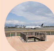
幅約61mの ウイングデッキ (大型旅客機の主翼同寸)
